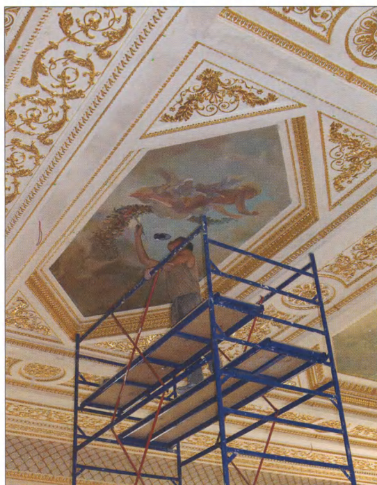
Реставрационные работы по внутреннему убранству дворца
