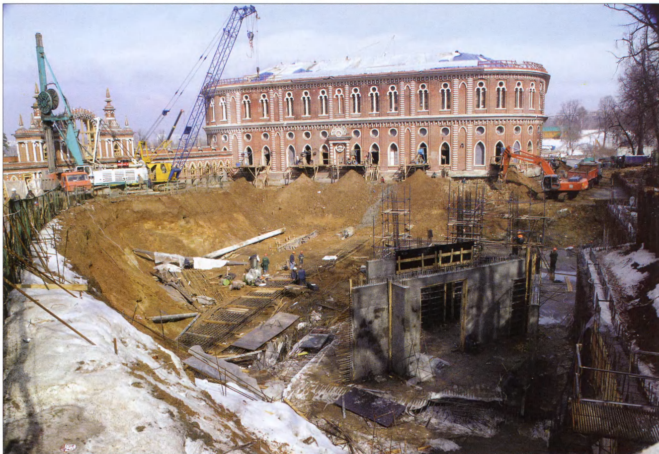
Реконструкция Хлебного дома. Фотография Н. Е. и П. В. Шибяевых
